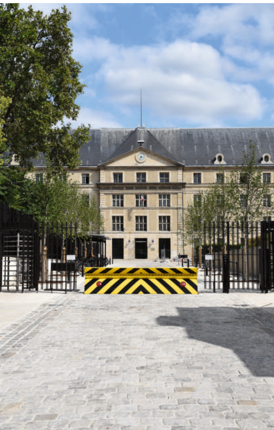
Le bureau infrastructure et maintenance du SAG a mené sur 2020 d'importants travaux, notamment sur le site de l'Hôtel national des Invalides.
